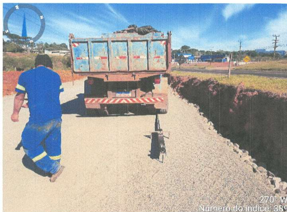
FIGURA 05 – Execução de viga Benkelman
