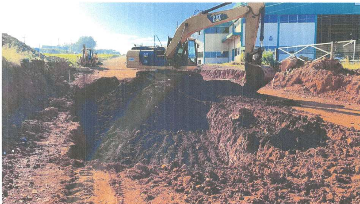
FIGURA 01 – Remoção de solos moles
